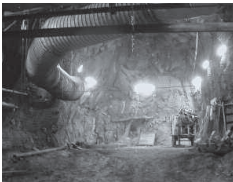
Excavation pour le nouveau laboratoire SNOLab près de Sudbury (Ontario), près de 2 km sous terre.
